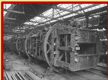
Lassers konden in zo'n roltrommel makkelijker werken.
