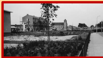
De flats aan de Dr. Plesmanlaan in aanbouw. Ook aan de St.-Jacobuskerk wordt gewerkt: die steekt nog maar enkele meters boven de grond...!
