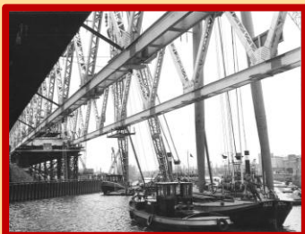
Een groot brugdeel wordt ingevaren. Vanaf de wal worden de aanwijzingen gegeven met een megafoon!
