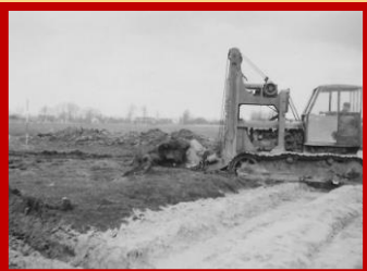
Aanvang grondwerken Schaakwijk
